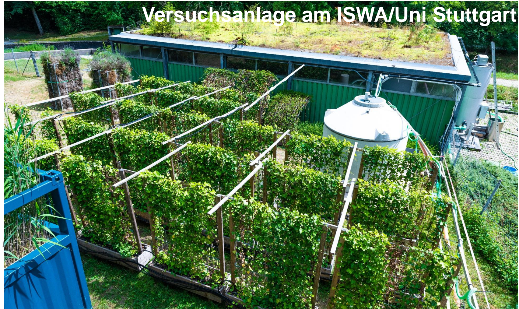
Abb.: Efeu-Fassadenmodule und das Gründach mit Betriebswasserspeicher.
