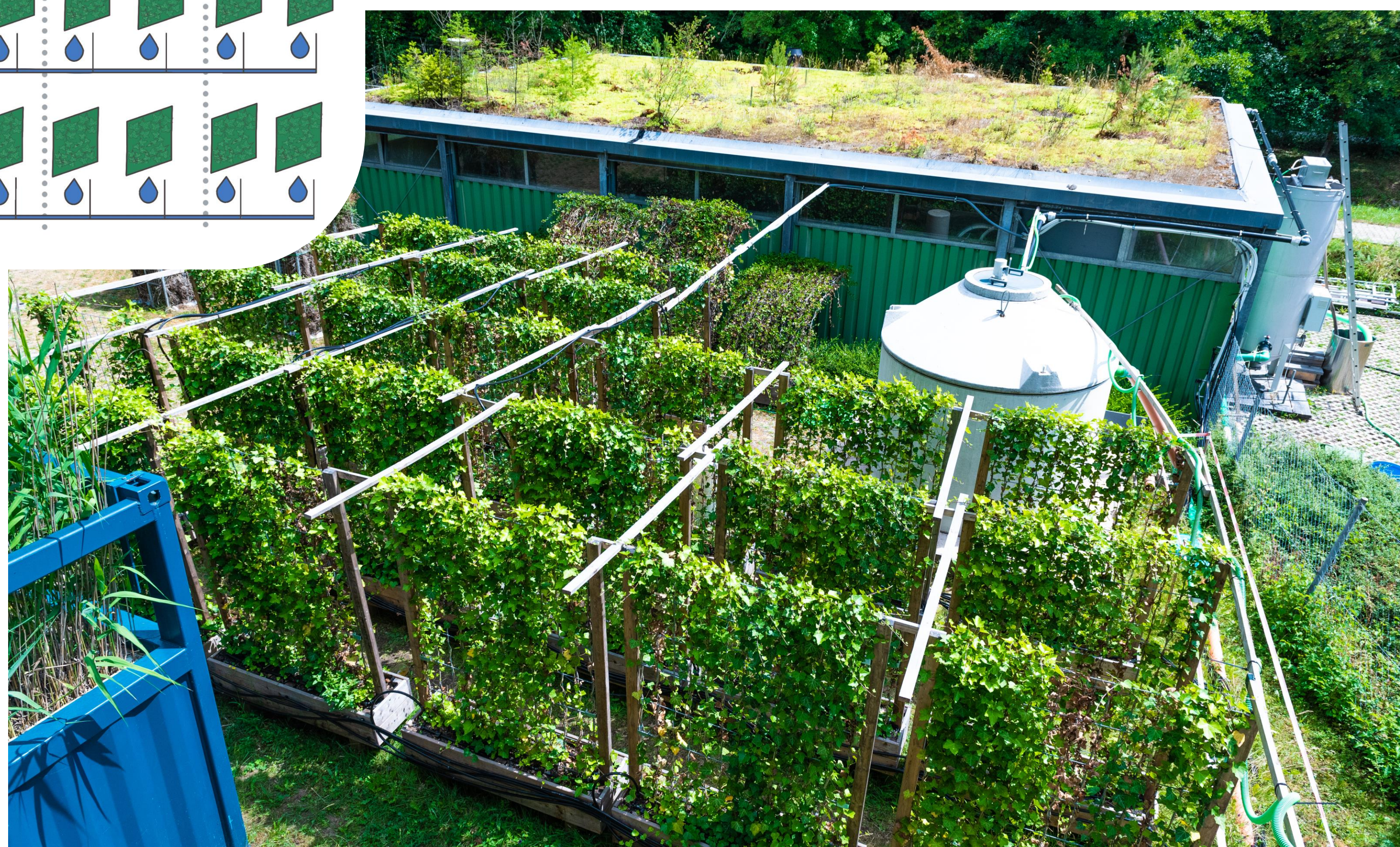
Abb. 2: EFEU-FASSADENMODULE, DIE MIT NIEDERSCHLAGSABFLÜSSEN UNTERSCHIEDLICHER AUFFANGFLÄCHEN BEWÄSSERT WERDEN, U. A. DAS GRÜNDACH SAMT BETRIEBSWASSERSPEICHER.
